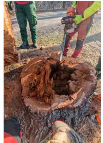
Fällung einer bruchgefährdete Eiche
